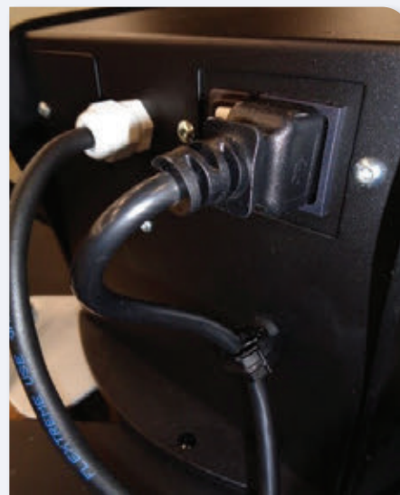
Kabel jest bezpiecznie zamocowany
